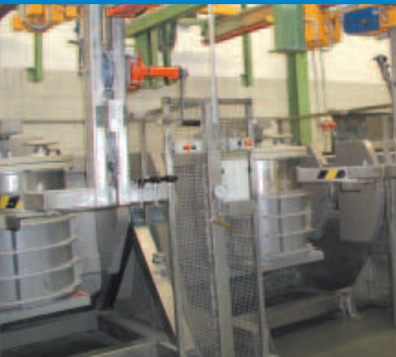
dyna-MIX mit Elektrohängebahn bei VARTA in der Batteriefertigung
